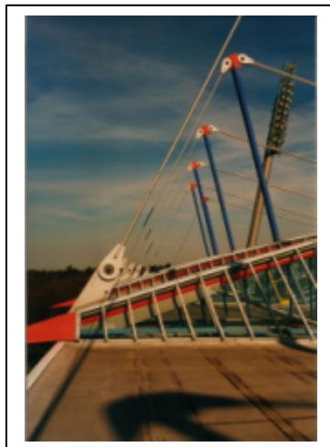
Seilkonstruktion der Dachabhängung
