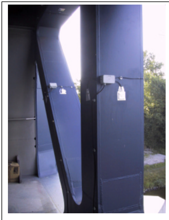
Dehnungsmessstellen am Fachwerk parallel zum Trog
